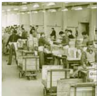
Halle zur Kontrolle, Sortierung und Verpackung in der Nachkriegszeit Hall de contrôle, de triage et d'emballage après la 2 e Guerre mondiale
