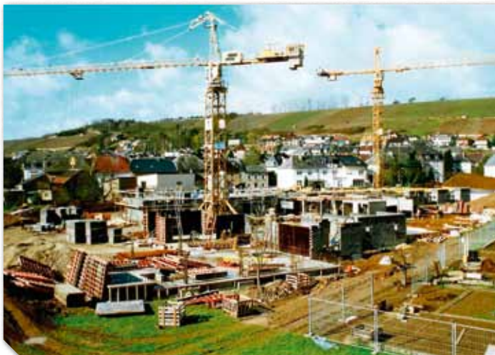
Das Pflegeheim in der Bauphase ... La maison de soins pendant la construction ...
