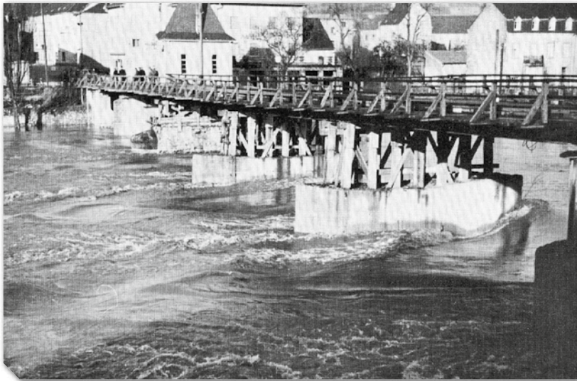
Die Notbrücke für den Straßenverkehr 1947 Le pont provisoire pour la circulation routière en 1947.
