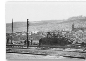
Wasserturm am Bahnhof Réservoir d'eau de la gare
