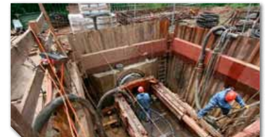
Bau der Verteilerstation in Mertert Construction du puits de distribution à Mertert
