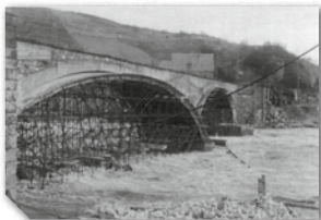
Die heutige Brücke in der Bau-phase 1950 Le pont actuel en phase de construction en 1950
