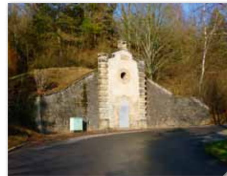
Wasserbehälter auf dem Bocksberg, 1906 erbaut, Speichervolumen 300 m 3 Réservoir au Bocksberg, construit en 1906, capacité de 300 m 3
