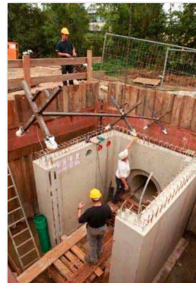
Die fertiggestellte Verteilerstation in Mertert / Puits de distribution achevé à Mertert
