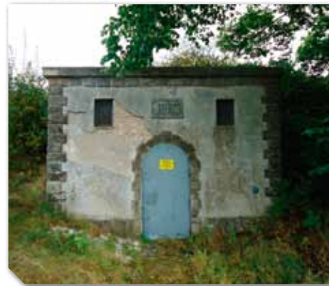
Wasserbehälter auf dem Widderberg, nord-westlich von Mertert, 1917 erbaut, Speichervolumen 80 m 3 , heute nicht mehr in Betrieb
