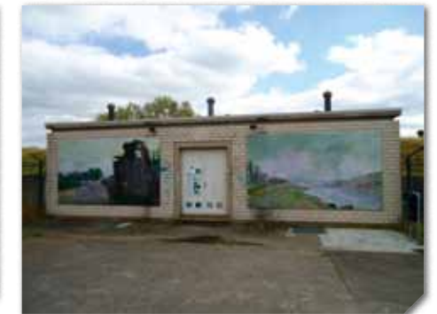
Wasserbehälter auf dem Wangertsberg, Speichervolumen 2 x 1.000 m 3 , Fertigstellung 1982 Réservoir au Wangertsberg, capacité de 2 x 1.000 m 3 , achèvement en 1982
