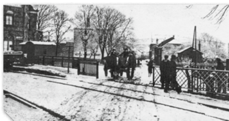
Bahnübergang mit Schranke im Jahre 1910 Passage à niveau avec barrière en 1910
