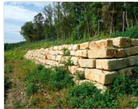
Trockenmauern Murs de pierres naturelles
