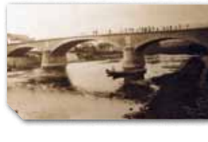
Die neue Brücke nach der Fertigstellung Le nouveau pont à la fin de sa construction
