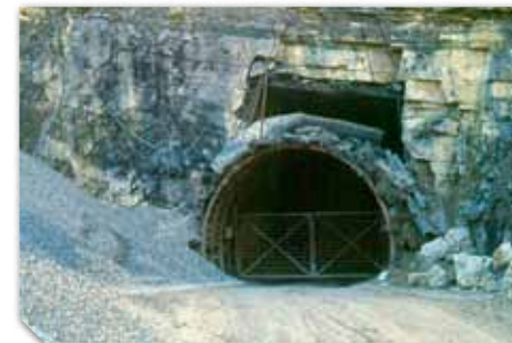
Stolleneingang / Entrée d'une galerie
