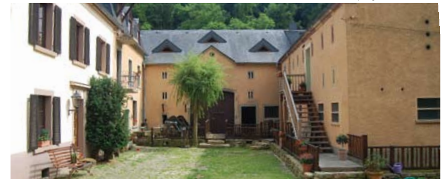
Altbäuerliche Bauten wie hier die „Steekemillen“, prägen den Charakter der kleinen Ortschaft Manternach.
