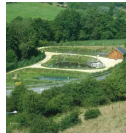
Die Teichkläranlage Münschecker.
