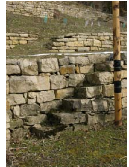
Restaurierte Trockenmauern in „Wangert“.
