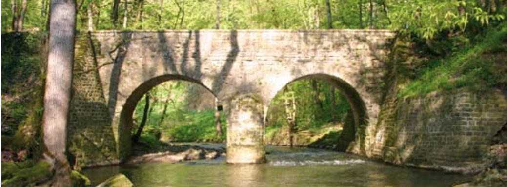
Das Aquädukt der Holzmillen ist im Großherzogtum in dieser Form einzigartig.
