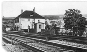
Das heute stillgelegte Bahnhofsgebäude der Wilhelm-Luxemburg-Bahn La gare de la ligne Guillaume-Luxembourg, aujourd'hui hors service
