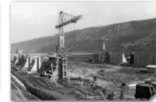
Bau der Kaimauern Construction des quais de transbordement
