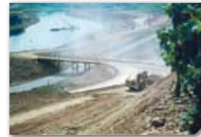
Erdarbeiten beim Hafenaufbau 1965 Terrassement sur le chantier du port en 1965
