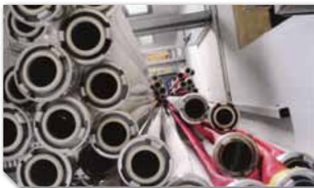
Schlauchturm innen Tour à tuyaux à l'intérieur
