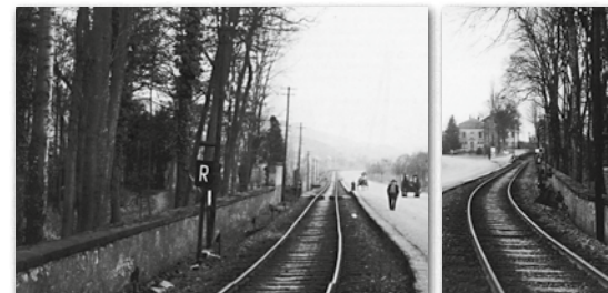
Die Prinz-Heinrich-Bahn in Mertert neben der Landstraße Mertert - Grevenmacher linkes Bild: Blick in Richtung Grevenmacher, links: der Merterter Park rechtes Bild: Blick in Richtung Merterter Bahnhof, rechts: der Merterter Park
