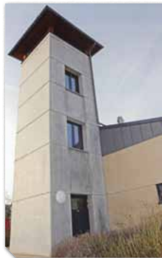
Schlauchturm Tour à tuyaux
