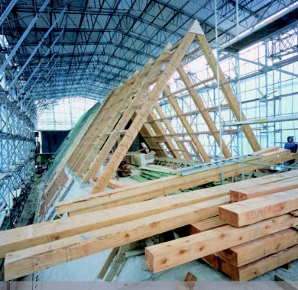
Bâtiment Abbaye, protection contre intempéries pour le renouvellement de la toiture Abteigebäude, Wetterschutz während der Erneuerung des Daches Abbey building, weather protection during renewal of the roof
