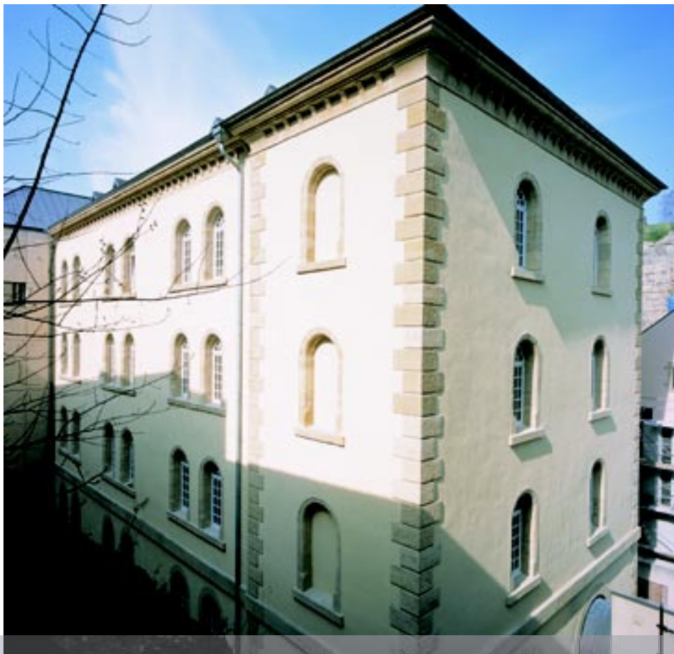
Bâtiment Robert Bruch (Criminel), Façade route de Trèves Robert Bruch-Gebäude (Criminel), Fassade zur route de Trèves Robert Bruch Building (Criminel), façade on the route de Trèves
