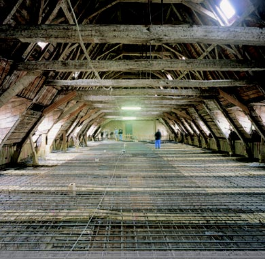
Abbaye, ancienne et nouvelle charpente Abtei, altes und neues Dachgebälk Abbey, old and new roof timbers
