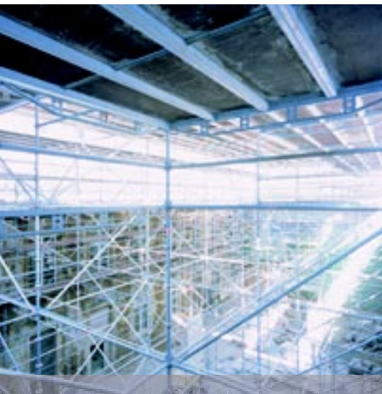
Abbaye, échafaudages pour verrière dans la cour intérieure Abtei, Gerüst für die Glasüberdachung im Innenhof Abbey, scaffolding for the glass roof over the inner courtyard
