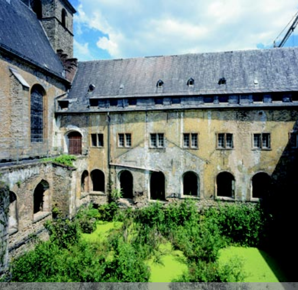
Jardin cloître avant travaux Klostergarten vor den Umbauarbeiten Cloister garden before works
